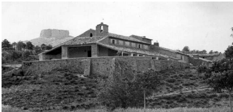
Ermita-Santuario de la Rogativa antes de las obras. Vista frontal
